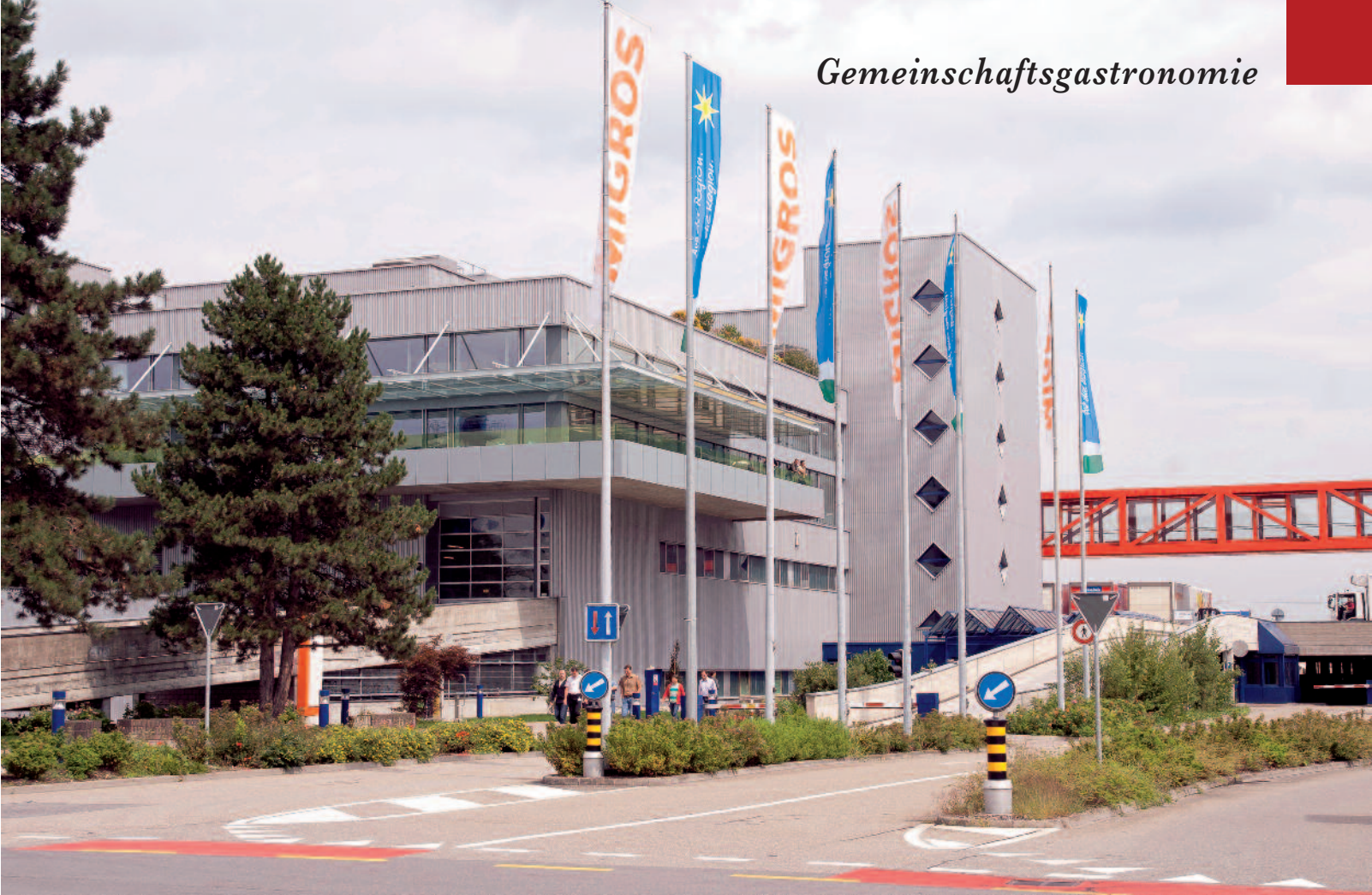
Blick zur Betriebs- und Verteilzentrale der Genossenschaft Migros Luzern in Dierikon.
